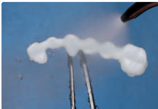
Vor dem ZirLiner Auftrag das Gerüst mit dem Dampfstrahler reinigen.
